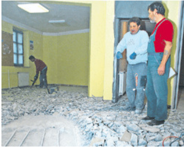
Hausmeister Dieter Johr (rechts) im Gemeindezentrum, das eine große Baustelle ist. Foto: Henson Stehling
